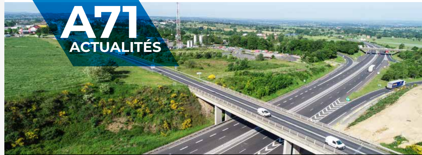
LETTRE D'INFORMATION DU CHANTIER DE L'ÉCHANGEUR DE MONTMARULT • N°1 OCTOBRE 2018
